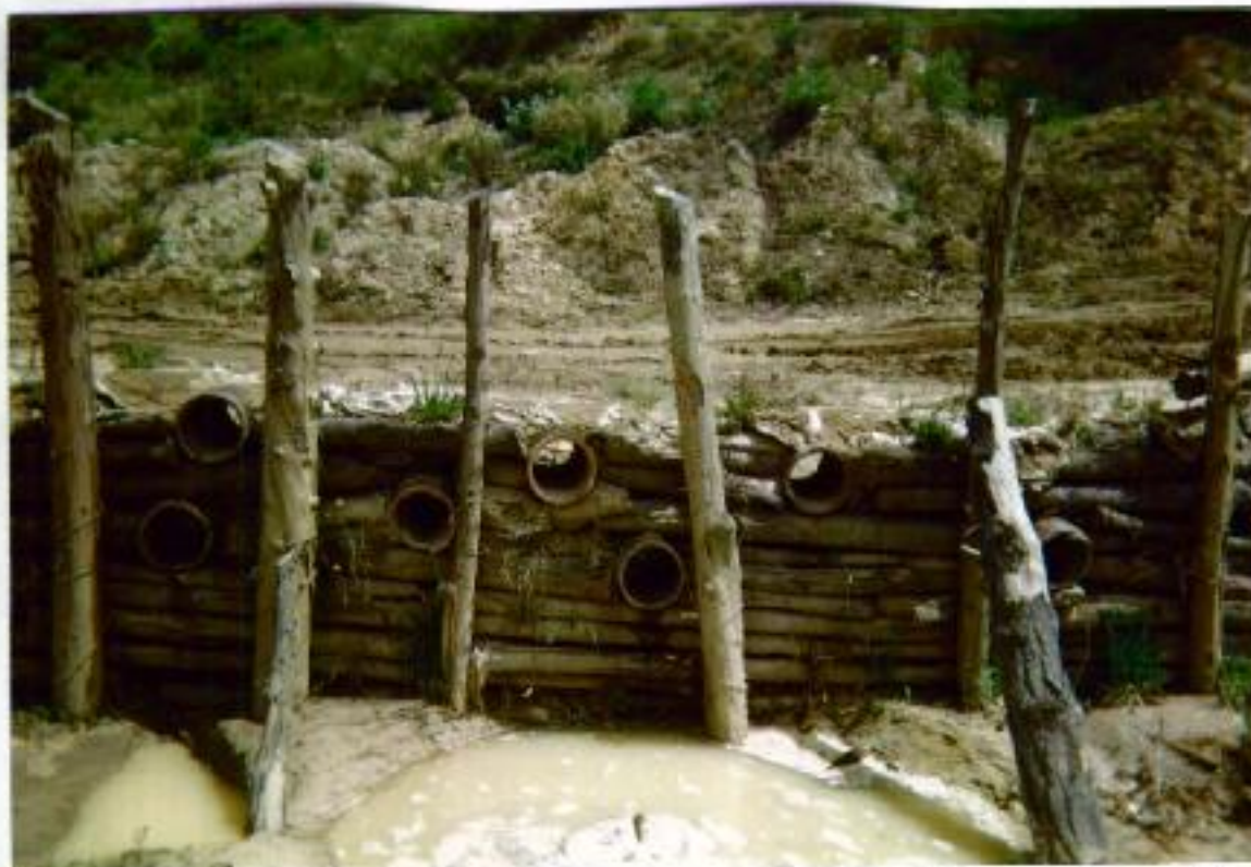
Trinchos típicos constituídos sobre el costado sur-oriental (Cantera Komauko).
