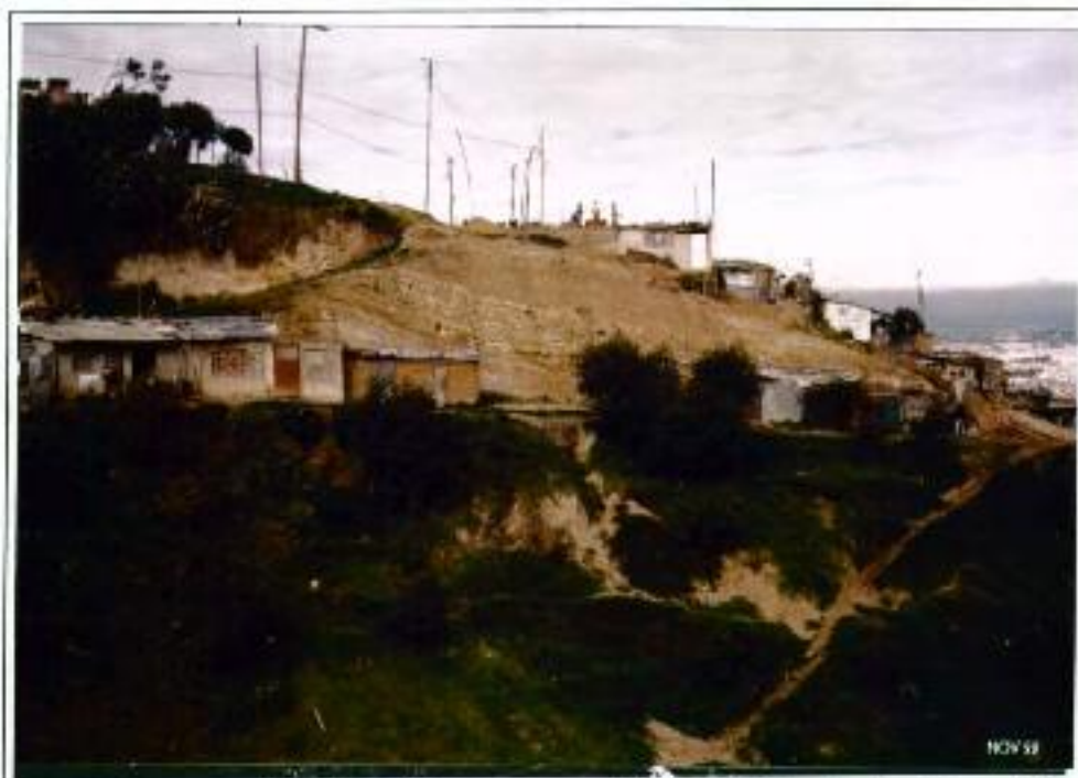
Foto 8. Vista general de los afloramientos de los niveles de limolitas silíceas en la parte alta del barrio Arauquita. Obsérvese la erosión laminar en las laderas y las cicatrices de movimientos en la capa de suelo que la suprayace.
