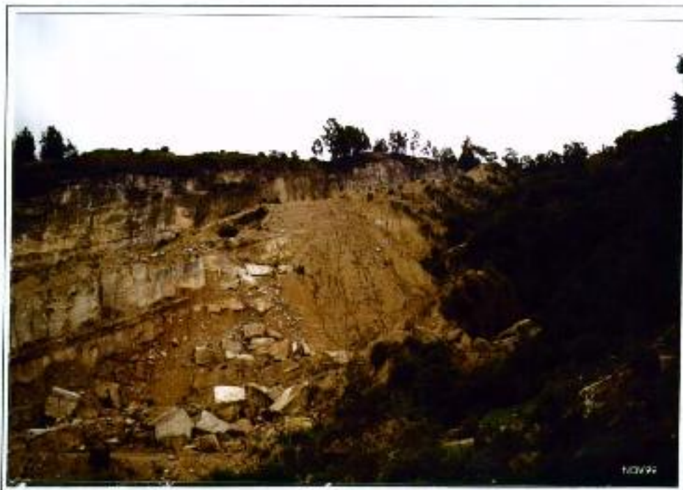
Foto 11. Escombrera en la cantera de la zona de estudio. Nótese la exposición los materiales a la acción de los agentes atmosféricos y la formación de pequeños surcos. Igualmente pueden presentarse caída de bloques que pueden afectar la quebrada.
