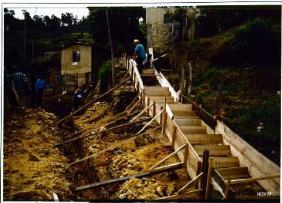
Foto 15. Obras que actualmente se están ejecutando en el barrio: el acueducto y las vías peatonales (escaleras).
