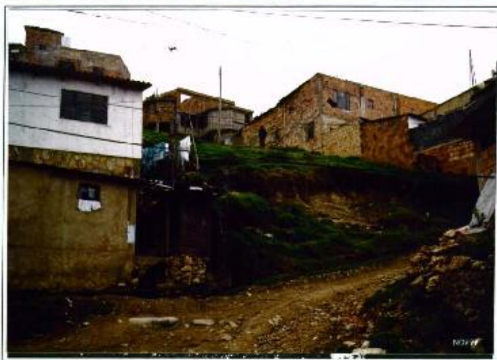
Foto 13. Zona de inestabilidad manifiesta dentro del barrio Santa Cecilia. Obsérvese en primer plano el afloramiento de limolitas y arcillolitas, y las cicatrices del movimiento en el suelo que yace sobre la unidad de roca consolidada.
