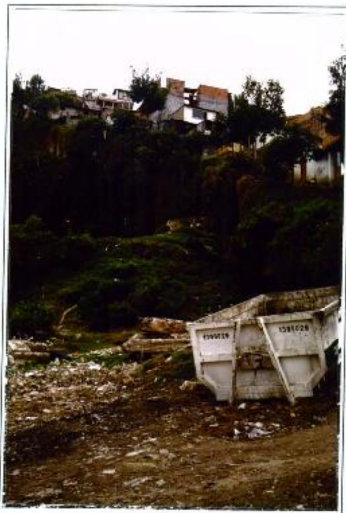
Foto 3. Detalle de las casas construidas al borde de un talud negativo (tapado por la vegetación).
