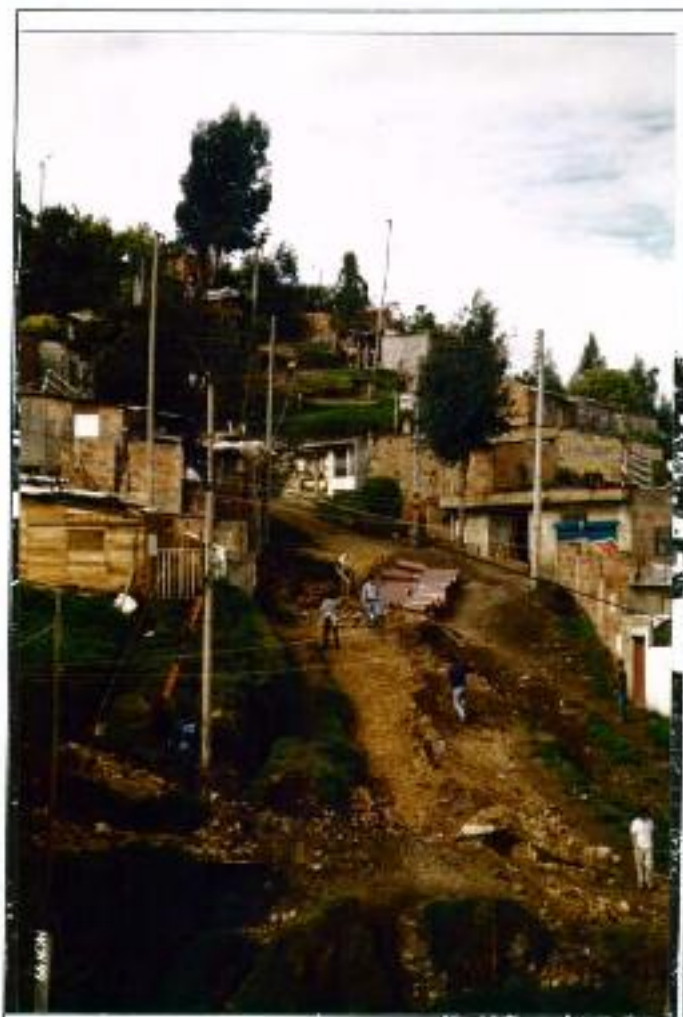
Foto 2. Muestra el estado de las vías "vehiculares" en el barrio Arauquita.
