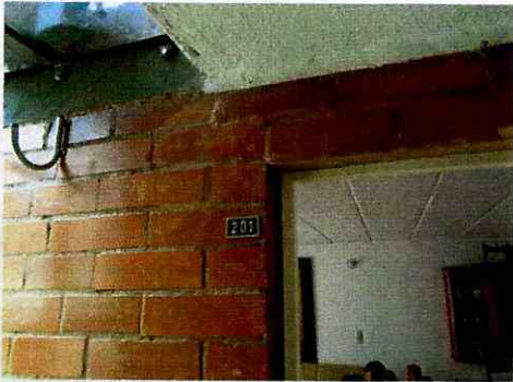
Fotografías 4 y 5. Fisuras en muros divisorios en el apartamento 201 del edificio de la Calle 152B No 136A-38
