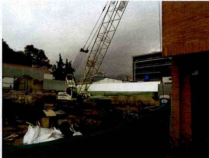
Fotografía 2. Obra aledaña en el predio de la Carrera 11B No98-36/48
