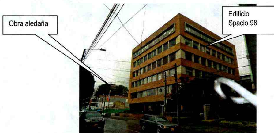
Fotografía 1. Predio de la Carrera 11B No 98-08- Edificio Spacio 98
