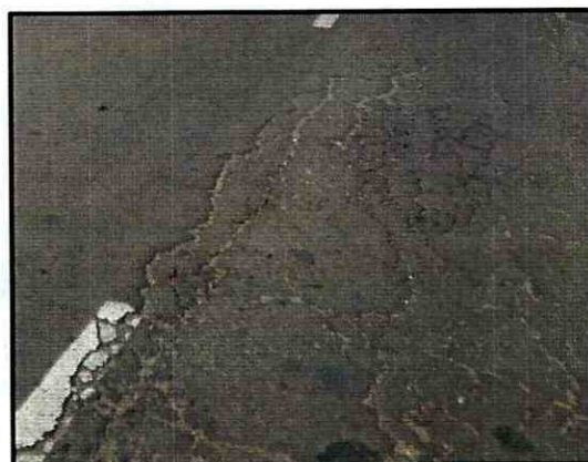
Fotografías 5 y 6. Rugosidades y fisuras en la Avenida Calle 153 frente al predio evaluado
