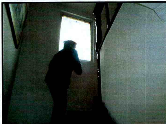
Fotografía 7. Interior 1 del predio de la Avenida Calle 153 No 19-24
