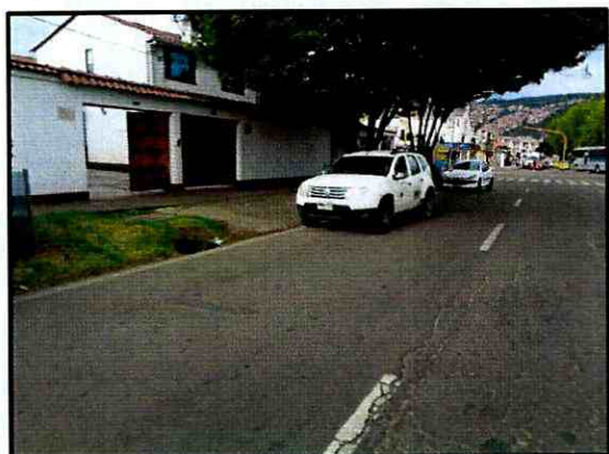
Fotografías 5 y 6. Rugosidades y fisuras en la Avenida Calle 153 frente al predio evaluado
