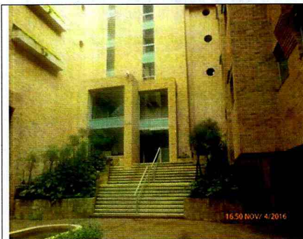
Foto 1. Conjunto residencial Balcones de Medina emplazado en el predio de la Carrera 5 No 131-96
