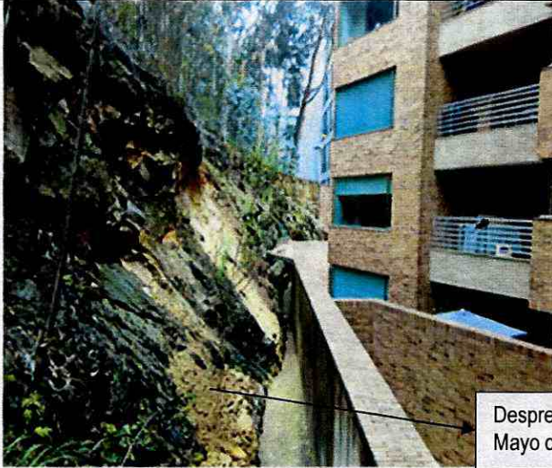
Foto 3 . Vista de los desprendimientos del talud rocoso ubicado al costado sur-oriental del Conjunto Residencial Balcones de Medina. DI-9861 (Nov - 2016)
