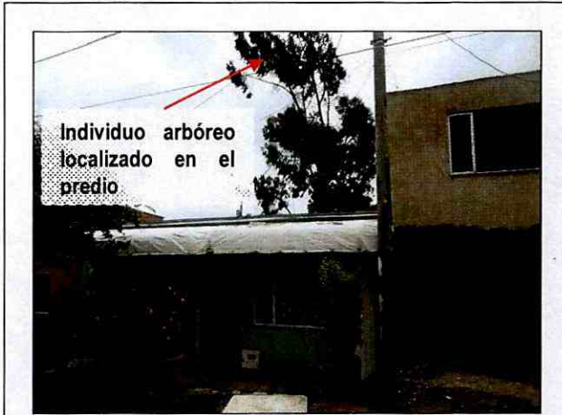
Fotografía 2. Vista de exterior del predio de la Calle 101 No. 5B-22 Este.
