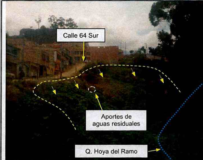
Fotografía 3. Vista del sector evaluado a la altura de la Calle 64 Sur entre la Carrera 1 Bis A y la Diagonal 63 Sur. Se observa el movimiento en masa identificado mediante el DI-5444 y uno de los puntos donde se vierten aguas residuales.
