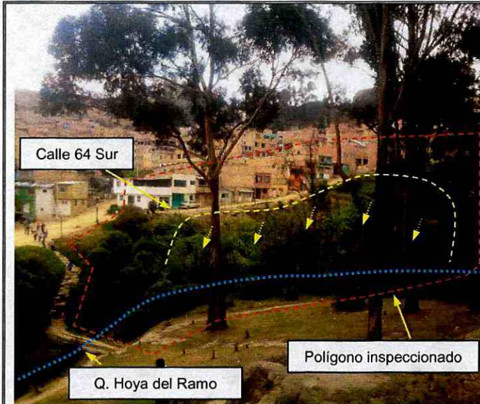
Fotografía 1. Vista del sector evaluado a la altura de la Calle 64 Sur entre la Carrera 1 Bis A y la Diagonal 63 Sur. Se observa el movimiento en masa identificado mediante el DI-5444.
