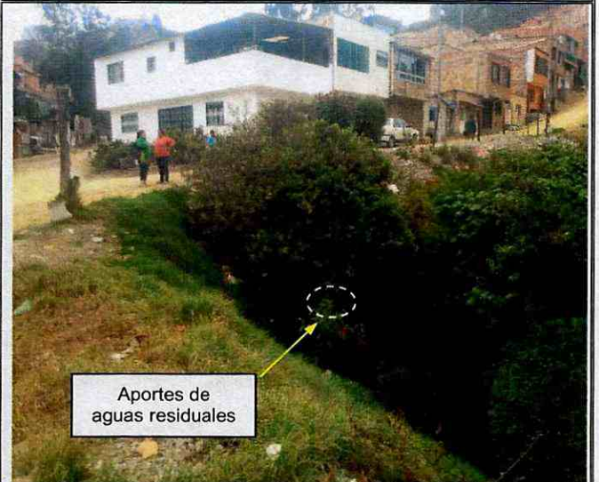
Fotografía 4. Vista del sector evaluado a la altura de la Calle 64 Sur entre la Carrera 1 Bis A y la Diagonal 63 Sur. Se observa uno de los puntos donde se vierten aguas residuales.
