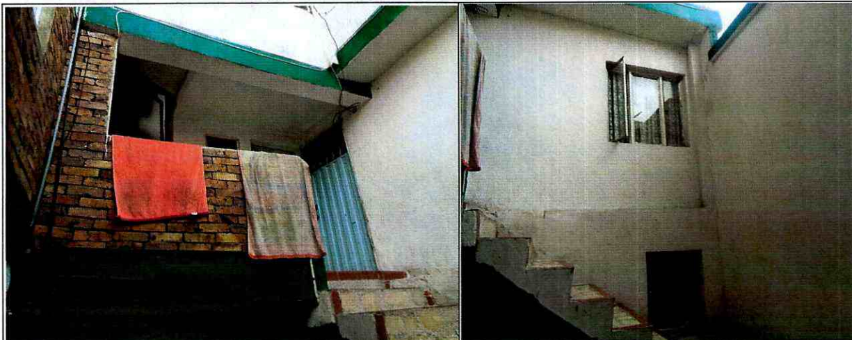
Fotografía 5 y 6. Vista al interior del predio de la Carrera 13C No 40I-15 Sur, del Barrio Granjas de San Pablo de la Localidad de Rafael Uribe Uribe.
