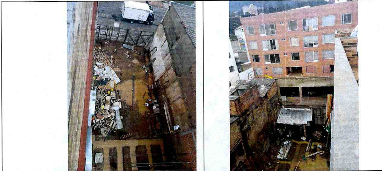
Fotografía 4 y 5. Vista general del predio de la Carrera 7 No. 7 – 28 Sur en el Sector Catastral San Javier en la Localidad de San Cristóbal. Predio en obra - Constructora Inmobiliaria Trébolis.
