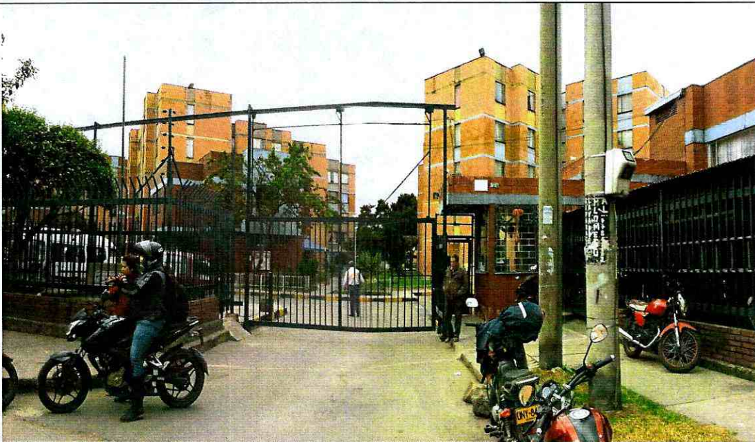
Foto 1: Vista de la conformación de la facha de la Urbanización Atlanta II Segundo Sector, de la Localidad de Ciudad Bolívar.
