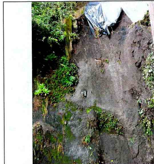
Fotografía 3 Vista del talud de corte al interior del predio de la Calle 91 No. 3 – 89 en el Sector Catastral El Refugio de la Localidad de Chapinero.
