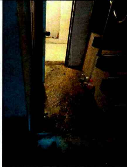
Fotografía 2. Vista al interior del sótano del Predio de la Carrera 8 No. 47 - 43 en el Sector Catastral Marly en la Localidad de Chapinero.
