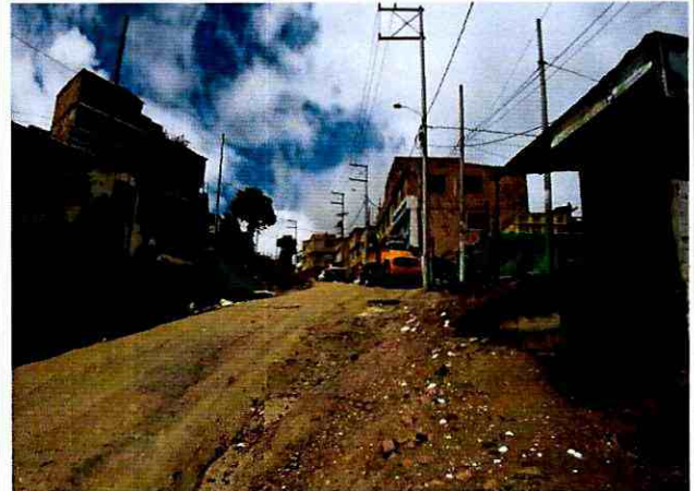
Fotografía 6. Tipo de edificaciones y vías ubicadas en el sector inspeccionado en el Barrio La Orquídea del Sur II Sector de la Localidad Usme.
