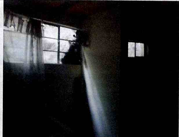
Fotografía 4. Vista de zona interna de P1, contiguo al talud donde se presentó el desprendimiento de material.
