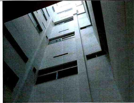
Fotografía 4. Vista de muro perimetral del apartamento 704, en zona de vano, se observa un buen estado de conservación.
