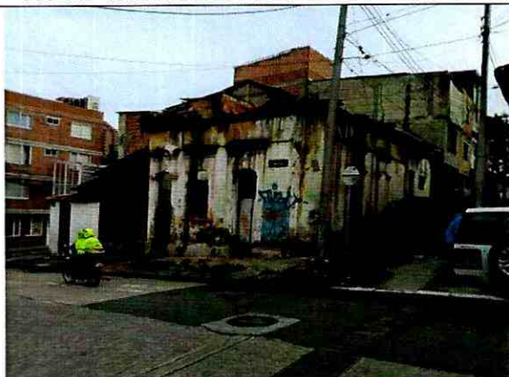
Fotografía 1. Vista de la fachada del predio de la Calle 31 No. 4 - 28 en el Sector Catastral La Perseverancia de la Localidad de Santa Fé.
