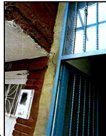
Fotografías 4 y 5. Fisuras en los muros de cerramiento junto a las entradas frontales del predio de la Carrera 89 No 80-87
