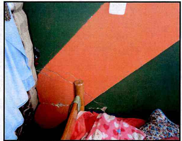
Fotografías 6 y 7. Fisuras en muros divisorios al interior del predio de la Carrera 89 No 80-87
