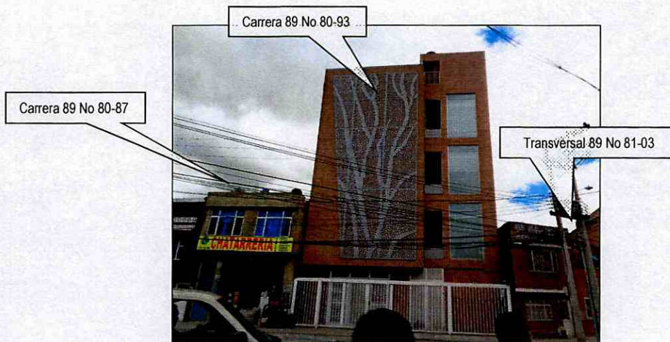
Fotografía 1. Predios de la Carrera 89 No 80-87, Carrera 89 No 80-93 y Transversal 89 No 81-03
