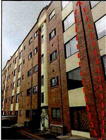
Fotos 3 y 4. Vista de la pérdida de verticalidad que presenta la Torre 7, con respecto a la Torre 8, y los daños que se identifican en el andén.
