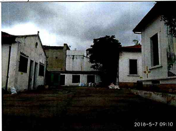
Fotografía 5. Vista de la construcción del predio costado oriental.
