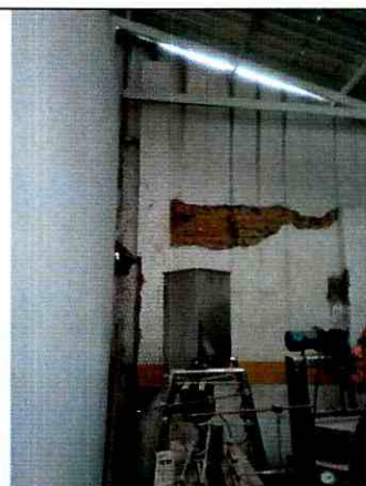
Fotografía 4. Vista interna del muro de fachada (costado oriental).
