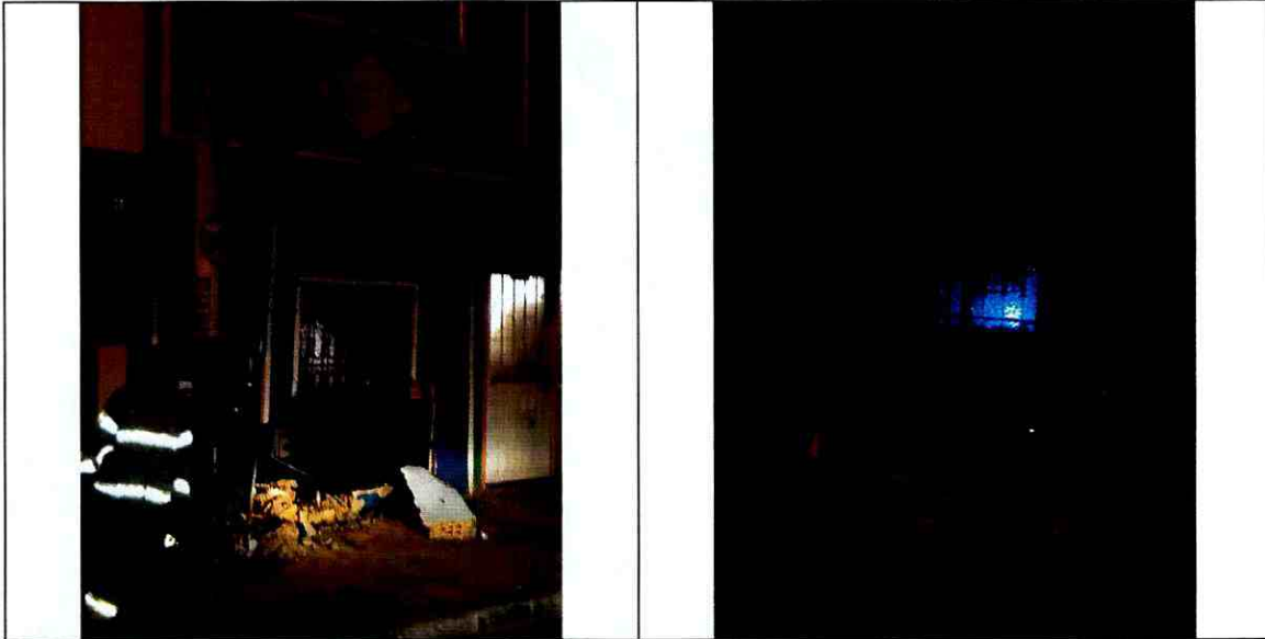
Fotografía 1. Vista de la fachada de la edificación, donde se presentó el impacto de vehículo automotor (vista externa).
