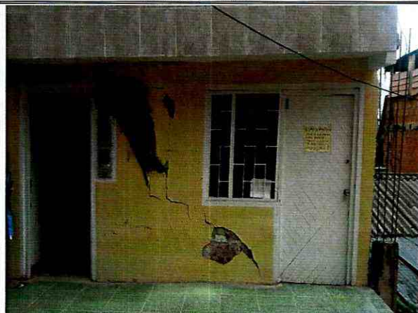
Foto No. 7 y 8. Condiciones muros divisorios y perimetrales vivienda emplazada en Predio 2. Fotografía tomada el 17/04/2018
