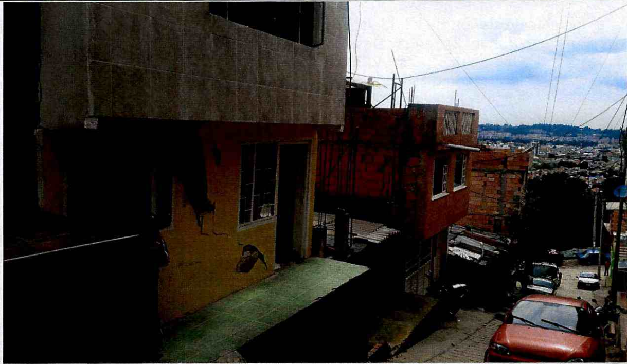
Foto No. 11. Viviendas que pudieran resultar afectadas (3, 4 y 5) por el posible colapso de la vivienda emplazada en el predio 2, ubicados en la Calle 164 A con Carrera 3, Desarrollo Santa Cecilia de la Localidad de Usaquén
