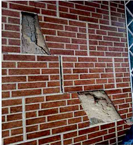
Foto No. 9. Vista frontal vivienda emplazada en predio 1. Tomada de DI-10849 – 22/05/2017
