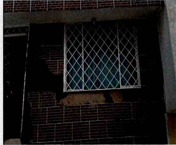
Foto No. 10. Vista frontal vivienda emplazada en predio 1. Fotografía tomada el 17/04/2018
