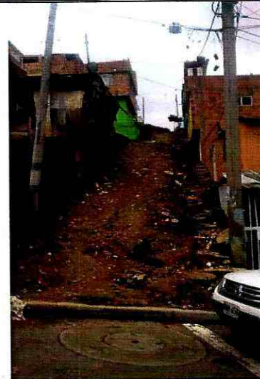
Fotografía 2. Carrera 18 R entre la Calle 63 y la Calle 63 A. Se observa que el tramo vial se encuentra sin pavimentar.
