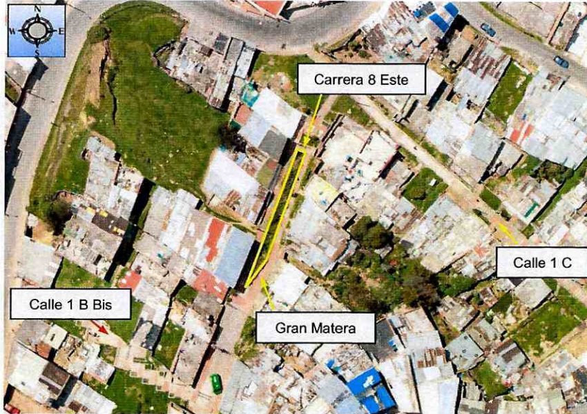
Figura 1. Aerofotografía del sector inspeccionado a la altura de la Carrera 8 Este entre la Calle 1 B Bis y la calle 1 C, en el Barrio El Dorado de la Localidad Santa Fe.
