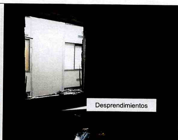
Fotografía 4. Techo del interior del apartamento 502, donde se observa el desprendimiento parcial del recubrimiento de techo.
