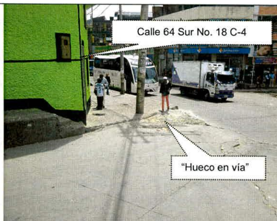
Fotografía 2. Vista de daño en la vía, frente al predio de la Calle 64 Sur No. 18 C-4.
