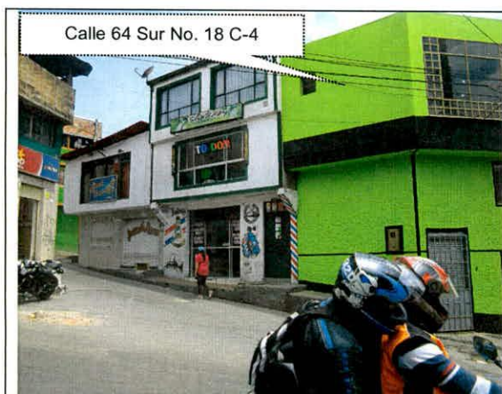
Fotografía 3. Vista de las edificaciones ubicadas en proximidades al daño en la vía.
