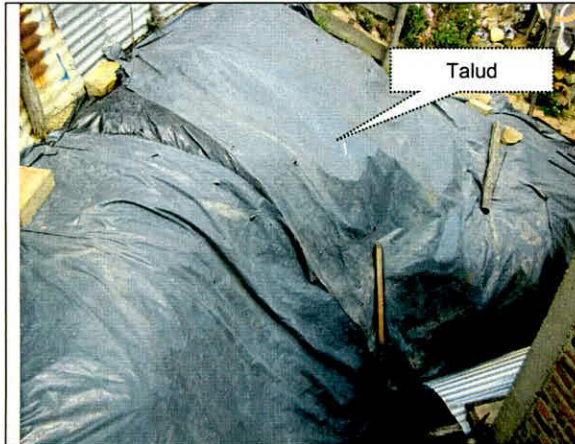
Fotografía 3. Vista del talud de corte en el predio, contiguo a la vía, se observa recubrimiento con plástico.
