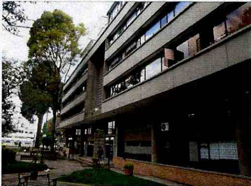
Fotografía 3 – Vista de la fachada sur de la edificación, imagen tomada el 26 de Marzo de 2018.
