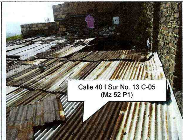
Foto 4. Visión de la cubierta de la vivienda del predio de la Calle 40 I Sur No. 13 C-05.
