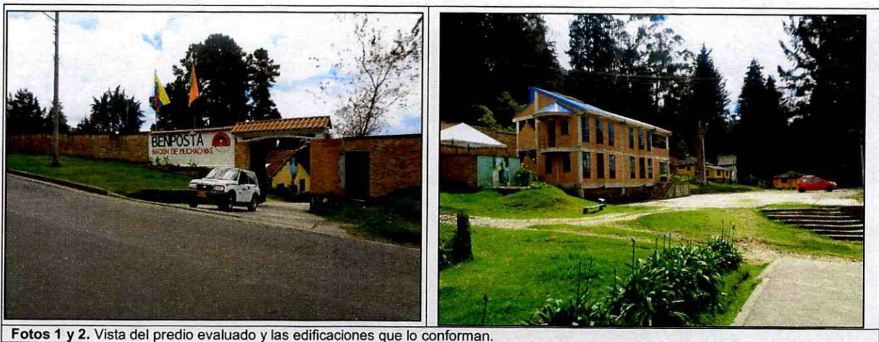
Fotos 1 y 2. Vista del predio evaluado y las edificaciones que lo conforman.
