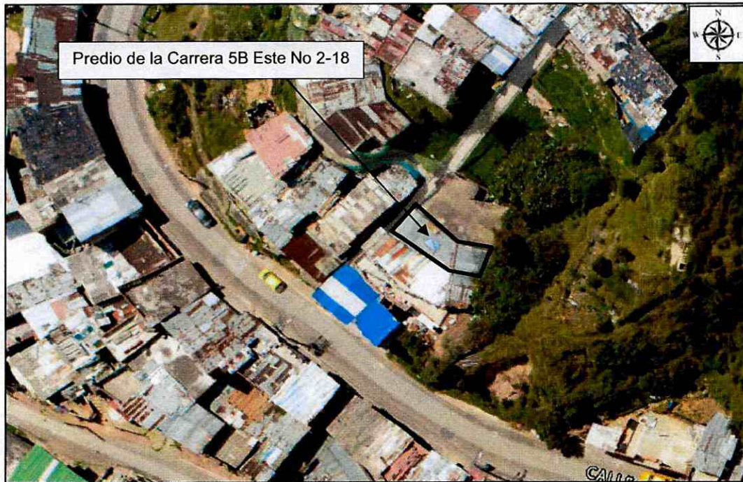
Figura No 1. Ubicación del predio visitado en atención al evento SIRE 4863313 en el barrio Santa Rosa de Lima de la Localidad de Santa Fe.
