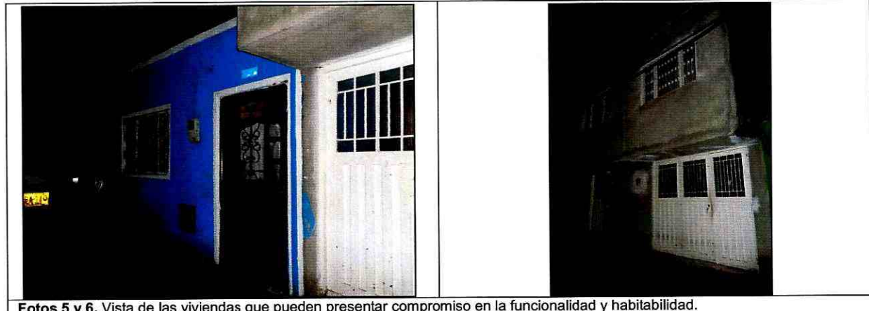
Fotos 5 y 6. Vista de las viviendas que pueden presentar compromiso en la funcionalidad y habitabilidad.
