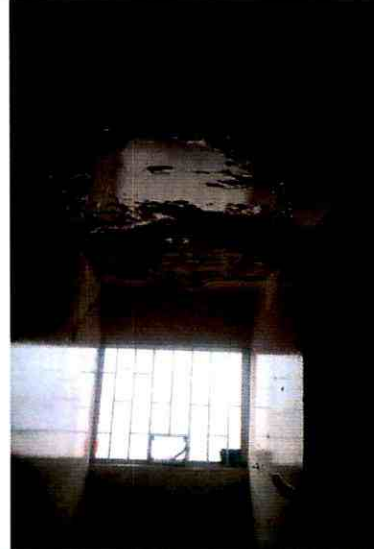
Fotografía 12. Deterioro en cielo raso (esterilla de guadua y mortero de recubrimiento) de dos cuartos del costado occidental de la edificación ubicada en el predio de la Calle 64 No. 121 – 60, en el Sector Catastral Engativá Zona Urbana de la Localidad Engativá.
