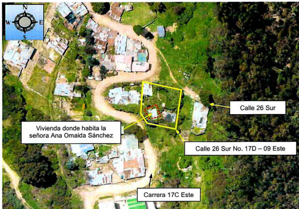
Figura 1. Aerofotografía del sector donde se ubica el predio de la Calle 26 Sur No. 17 D – 09 Este, en el Desarrollo Manantial de la Localidad San Cristóbal.
