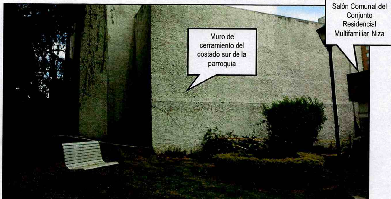
Fotografía 2. Muro perimetral del costado sur de la parroquia San Juan Crisóstomo colindante con el Conjunto Residencial Multifamiliar Niza
