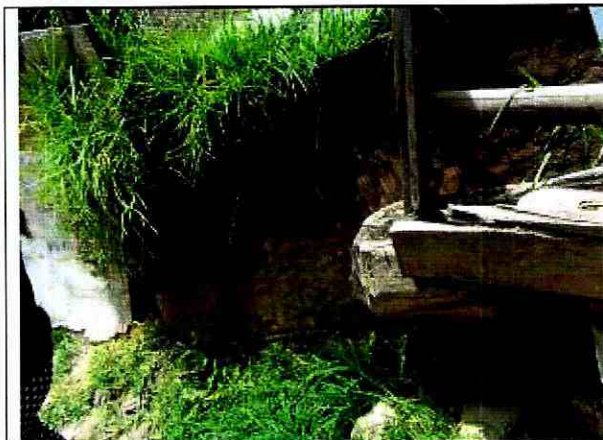
Fotografía 7. Soportes en material de recuperación del predio aledaño a la vivienda de la Carrera 2 Bis No. 41 B - 56 Sur, en el Barrio San Martín de Loba de la Localidad de San Cristóbal.
