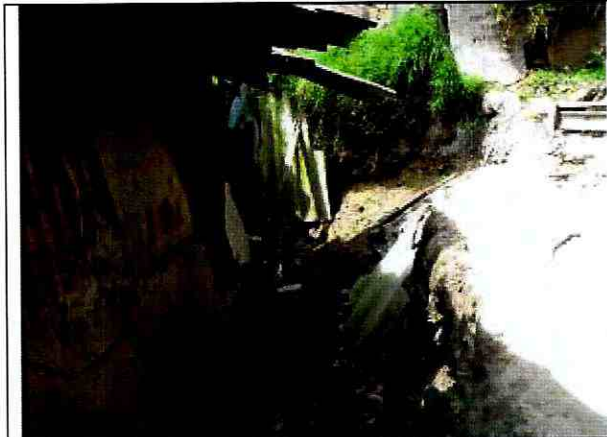
Fotografía 5. Acceso a la unidad habitacional de la parte baja del predio de la Carrera 2 Bis No. 41 B - 56 Sur, en el Barrio San Martín de Loba de la Localidad de San Cristóbal.
