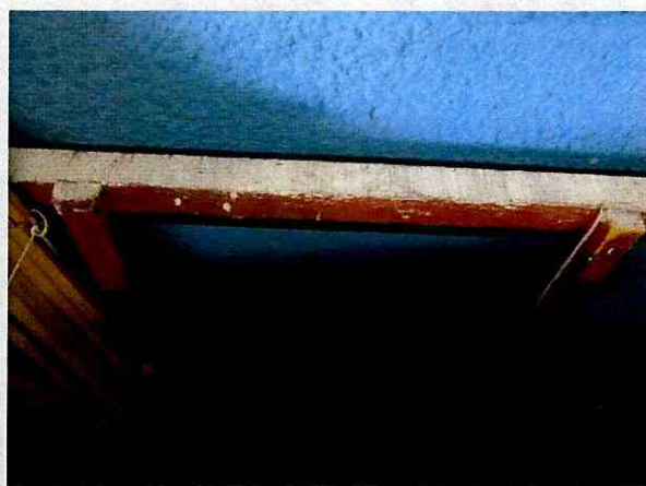
Fotografía 5 – Vista al interior del primer nivel del predio con dirección Transversal 72 D Bis No. 39 I – 23 Sur del Sector Catastral La Campiña de la localidad Kennedy, en la zona del colector común a ambas viviendas. No se observan humedades ni afloramientos de agua
