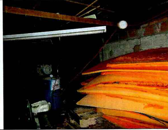
Fotografía 8. Vista de muro perimetral de segundo nivel en el predio de la Tv. 80 B No. 65 F – 40 Sur, no se observan daños.
