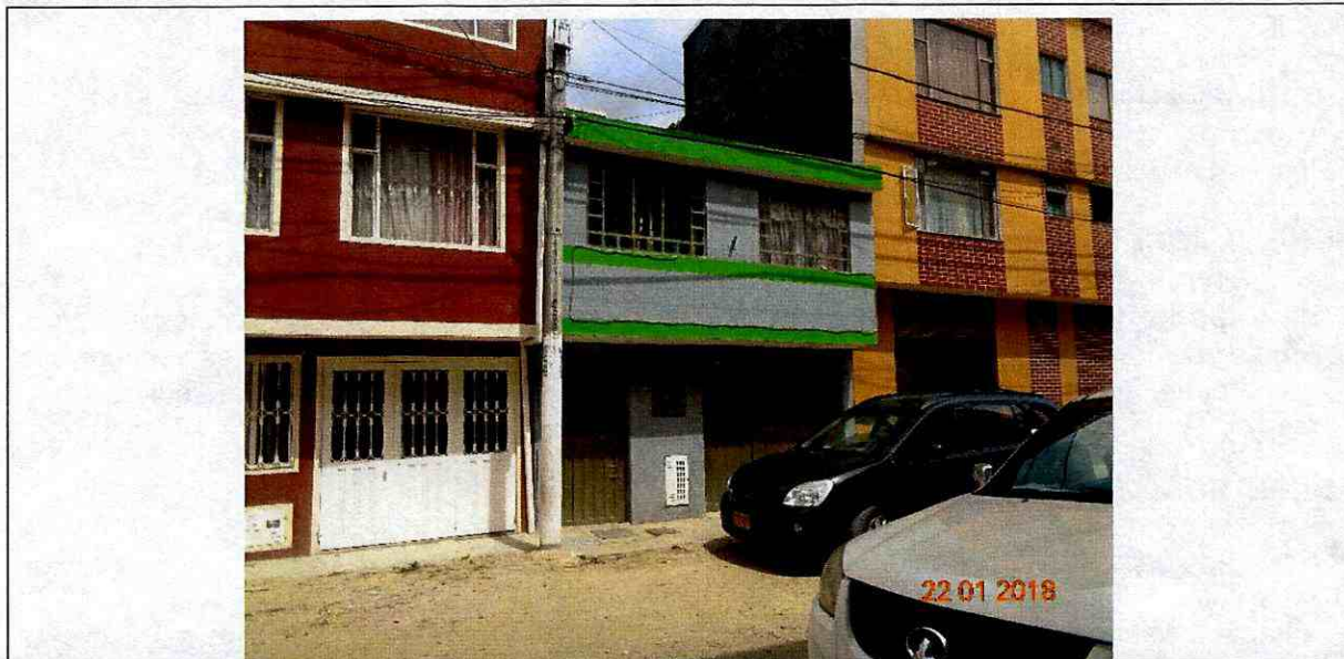
Fotografía 1: Vista de la fachada del predio de la Calle 143 N° 139-12, de la Localidad de Suba
