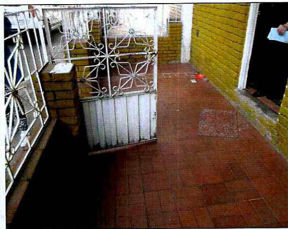
Fotografía 4. Vista de zona de antejardín, no se observan daños importantes en piso.
