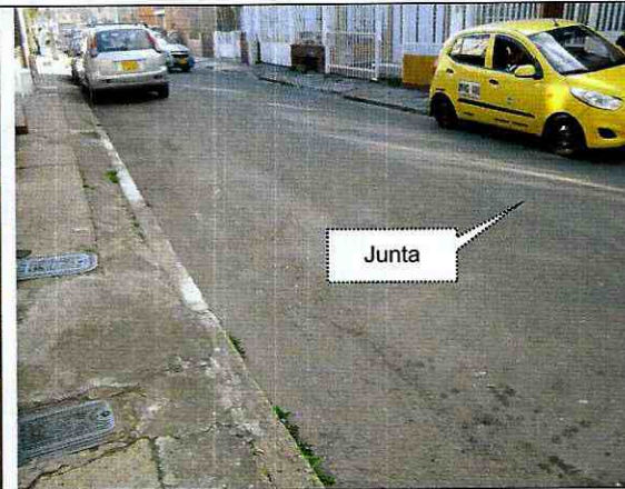
Fotografía 6. Vista de la vía frente al predio evaluado, no se observan daños importantes, se observa junta constructiva.
