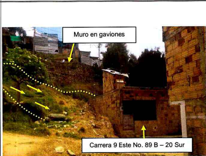
Fotografía 2. Vista del sector inspeccionado a la altura de la Carrera 9 Este con Calle 89 B Sur, en el Barrio Sierra Morena de la Localidad Usme, en donde se observa el movimiento en masa identificado desde Junio de 2004.
