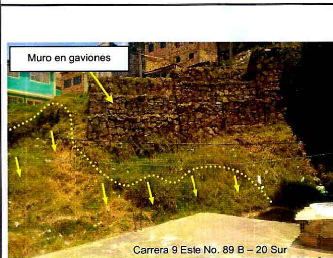
Fotografía 2. Vista del sector inspeccionado a la altura de la Carrera 9 Este con Calle 89 B Sur, en el Barrio Sierra Morena de la Localidad Usme, en donde se observa el movimiento en masa identificado desde Junio de 2004.
