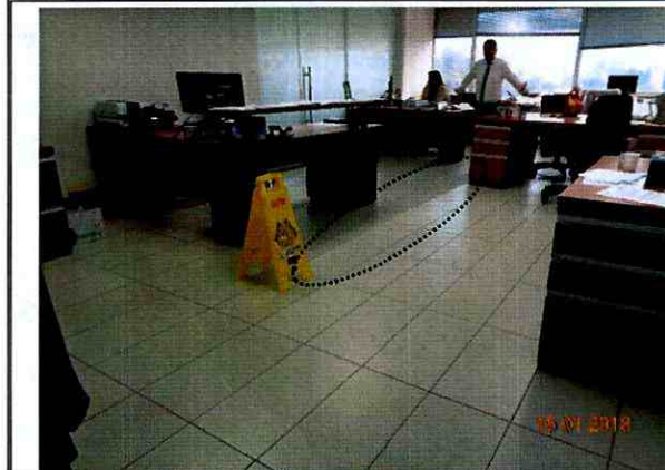
Foto No. 3 y 4. Levantamiento de baldosas
