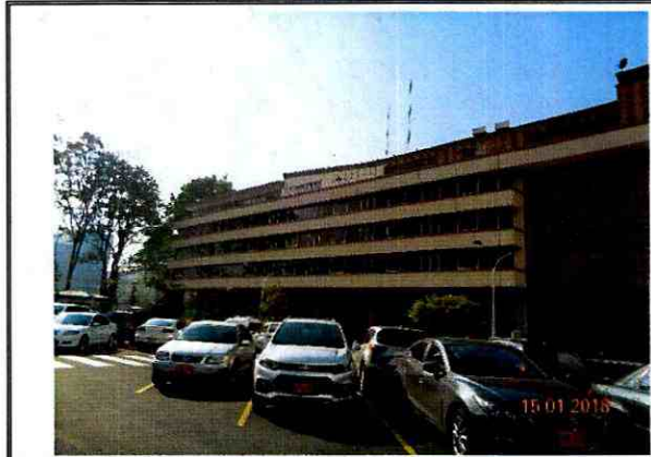
Foto No. 1. Vista frontal edificación emplazada en el predio de la Calle 43 No. 57 - 41
