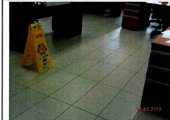
Foto No. 5. Levantamiento de baldosas
