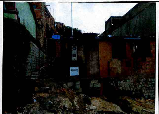
Foto 2. Vista de la vivienda evaluada, en el Desarrollo San Luis Altos del Cabo de la Localidad de Chapinero.
