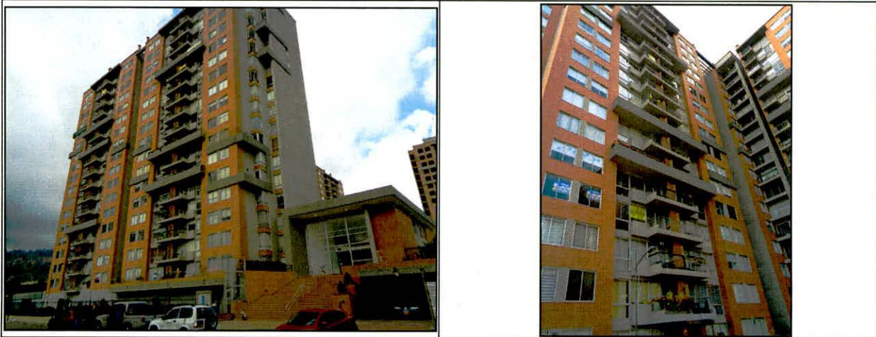
Fotos 1 y 2. Vista del Club Residencial Miramont y la Torre 1 evaluada.
