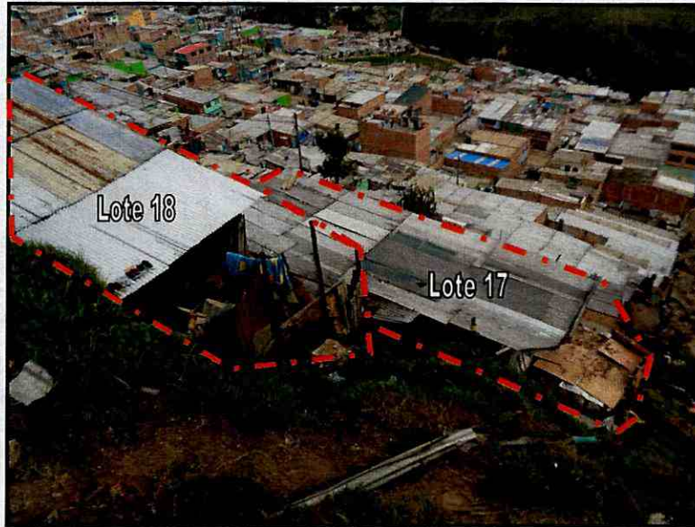
Fotografía 3. Vista de las viviendas evaluadas.
