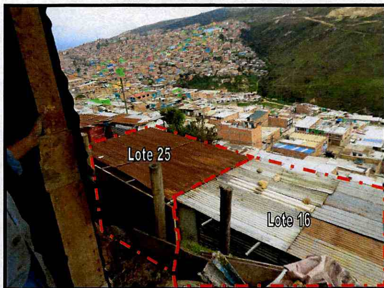
Fotografía 8. Vista de las viviendas emplazadas en el Lote 16 y 25 de la Manzana 24, las cuales pudieren presentar compromiso en su estabilidad.
