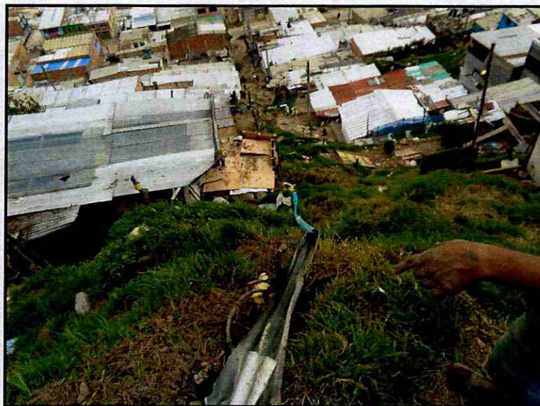
Fotografía 4. Vista de la canalización artesanal realizada por los habitantes del sector para conducir las aguas servidas.
