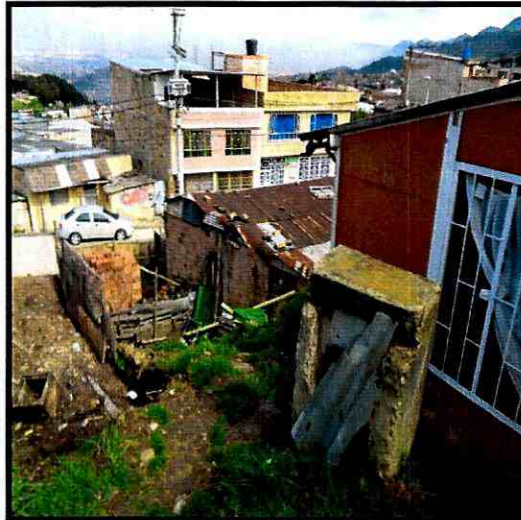
Fotografía 7. Contador de gas frente al predio de la Calle 71 A Sur No. 13 B – 14 Este (Unidad Habitacional del costado sur)
