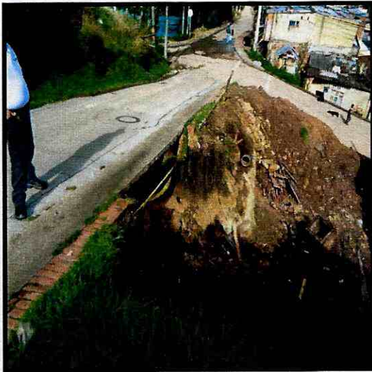
Fotografías 5 y 6. Socavación bajo la Calle 71 A Sur frente al predio de la Calle 71 A Sur No. 13 B – 14 Este
