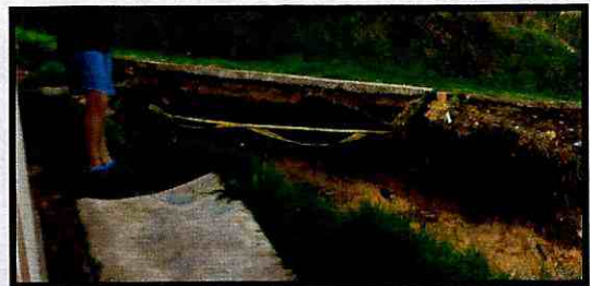
Fotografías 5 y 6. Socavación bajo la Calle 71 A Sur frente al predio de la Calle 71 A Sur No. 13 B – 14 Este
