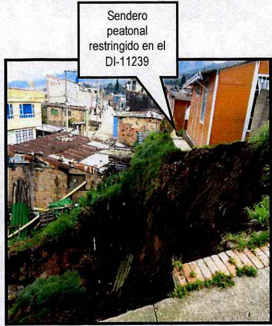
Fotografía 4. Sendero peatonal restringido en el Diagnóstico técnico DI-11239
