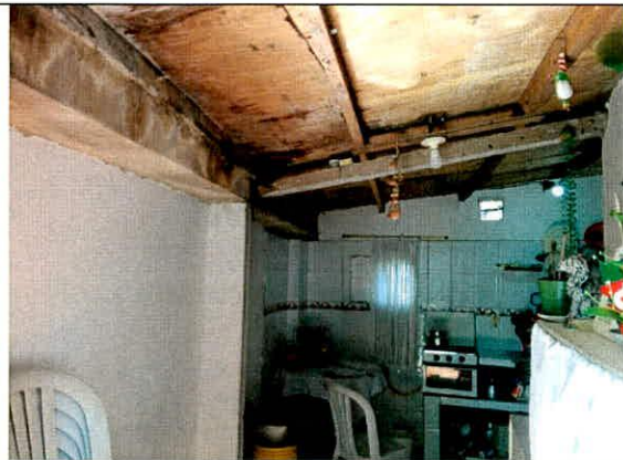
Fotografía 2. Vista al interior del predio de la Carrera 18 D No. 81 C-10 Sur en el el Sector Catastral Quiba Urbano de la Localidad de Ciudad Bolívar
