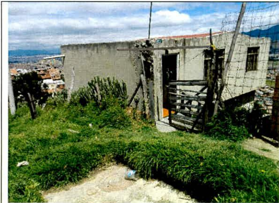
Fotografía 1. Fachada del predio de la dirección de la Carrera 18 D No. 81 C-10 Sur en el el Sector Catastral Quiba Urbano de la Localidad de Ciudad Bolívar
