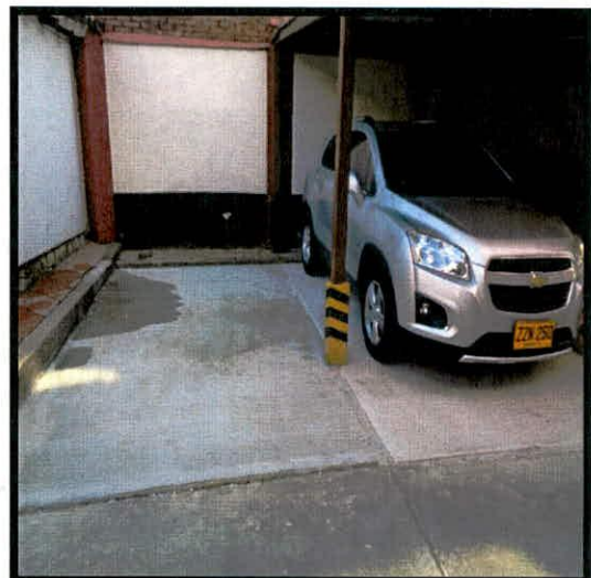
Fotografía 7. Estado de los parqueaderos 1 y 2 el día 21 de Diciembre de 2017
