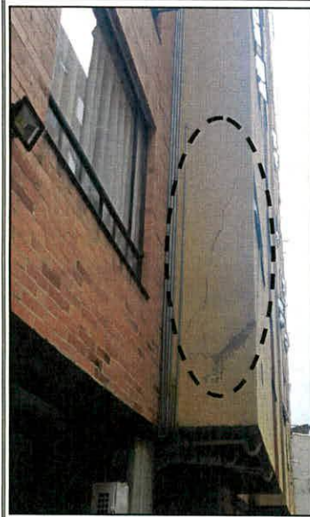
Fotografía 6. Izquierda. Fisuras en muro de cerramiento sobre voladizo tomada el 05 de Diciembre de 2017. Derecha. Fisura en muro de cerramiento sobre voladizo tomada el 01 de Julio de 2014. No se observa cambios.
