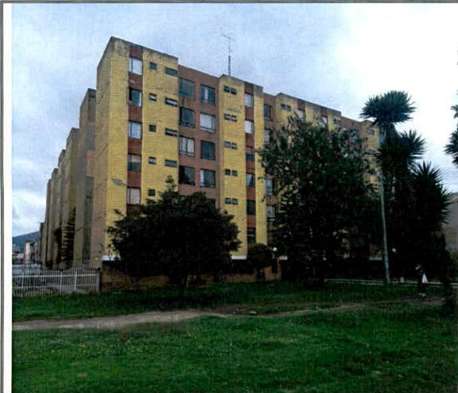
Fotografía 2. Vista del conjunto residencial Las Orquídeas, ubicado en el predio de la Calle 161 No. 12 B – 30, en el Sector Catastral La Pradera Norte de la Localidad Usaquén.
