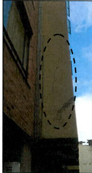
Fotografía 6. Izquierda. Fisuras en muro de cerramiento sobre voladizo tomada el 05 de Diciembre de 2017. Derecha. Fisura en muro de cerramiento sobre voladizo tomada el 01 de Julio de 2014. No se observa cambios.
